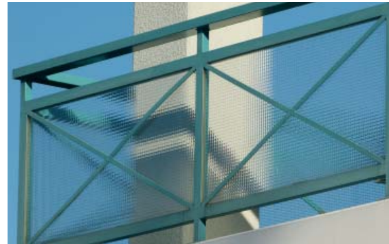
Balcó amb envidrament semitransparent, aquí de vidre emmollat: no és perillós per als ocells.
