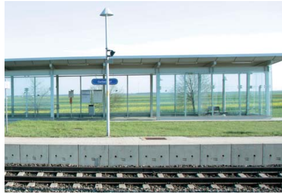
Sala d'espera completament de vidre
