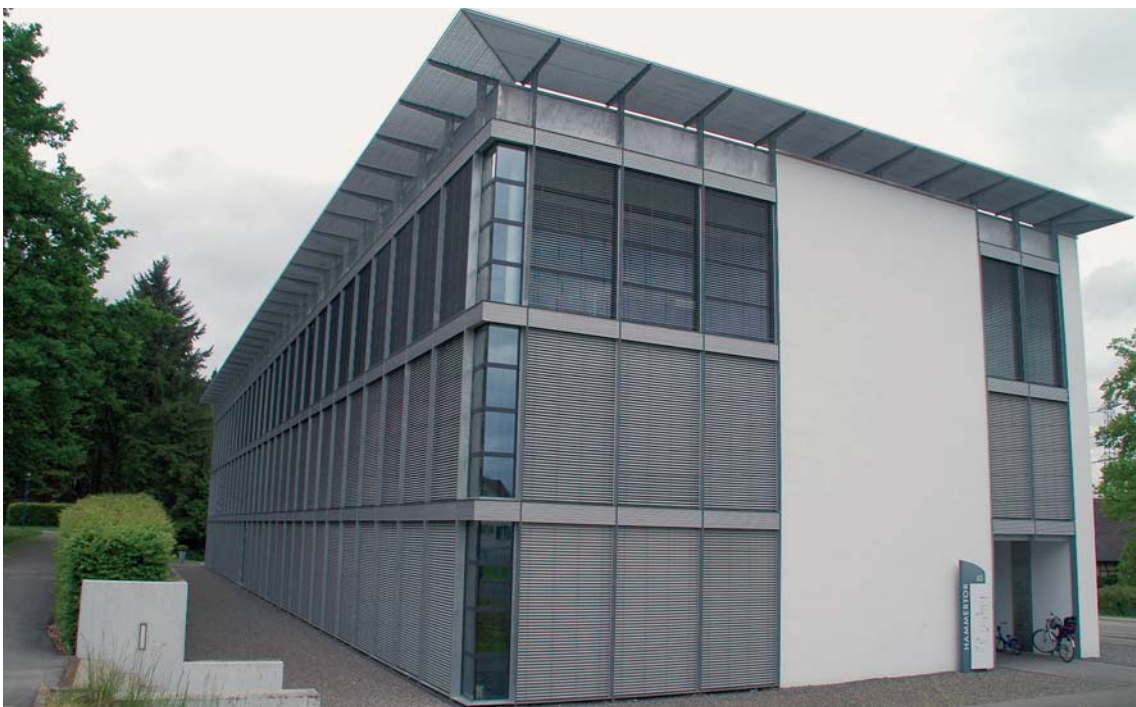
Aquest edifici és exemplar: les persianes es tanquen automàticament el cap de setmana i al final de la jornada laboral.
