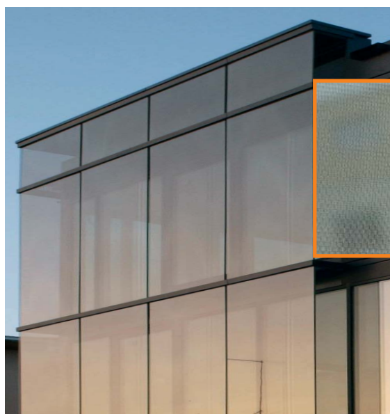
Les lamel·les verticals en el vidre redueixen la reflexió externa i protegeixen del reflex del sol, però permeten als usuaris veure l'exterior.
