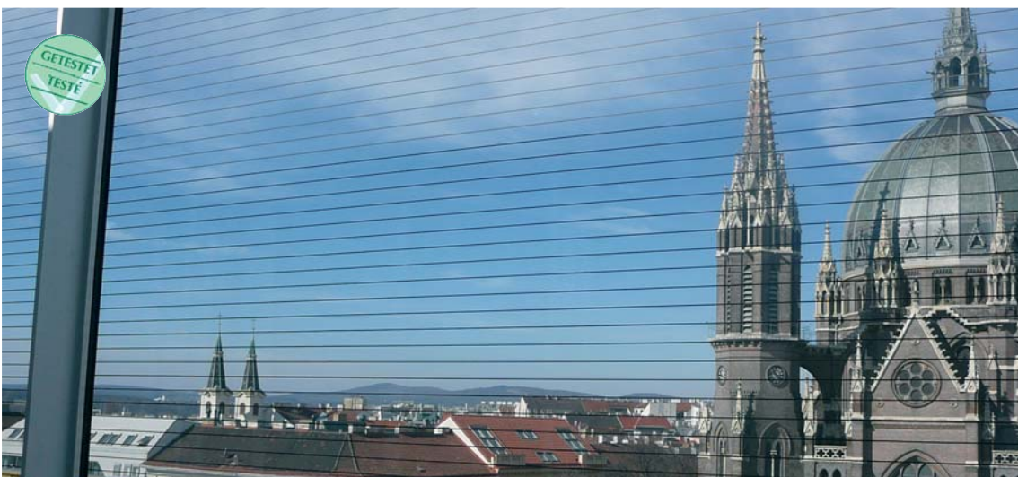
Contra totes les expectatives, les línies negres horitzontals de 2 mm de diàmetre i amb un interval de 28 mm van tenir molt bons resultats a les proves del túnel de vol. Allà on és important tenir la millor visibilitat possible davant de fons il·luminats, aquesta és una solució de compromís acceptable. En aquests casos, recomanem, però, que les línies tinguin almenys 3 mm d'ample.
