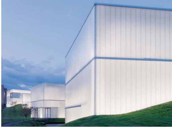
La dispersió de la llum de doble vidre a doble coberta de vidre en perfil d'U aprofita millor la llum natural i redueix significativament les pèrdues de calor. A més, proporciona il·luminació uniforme per a tota l'habitació.
