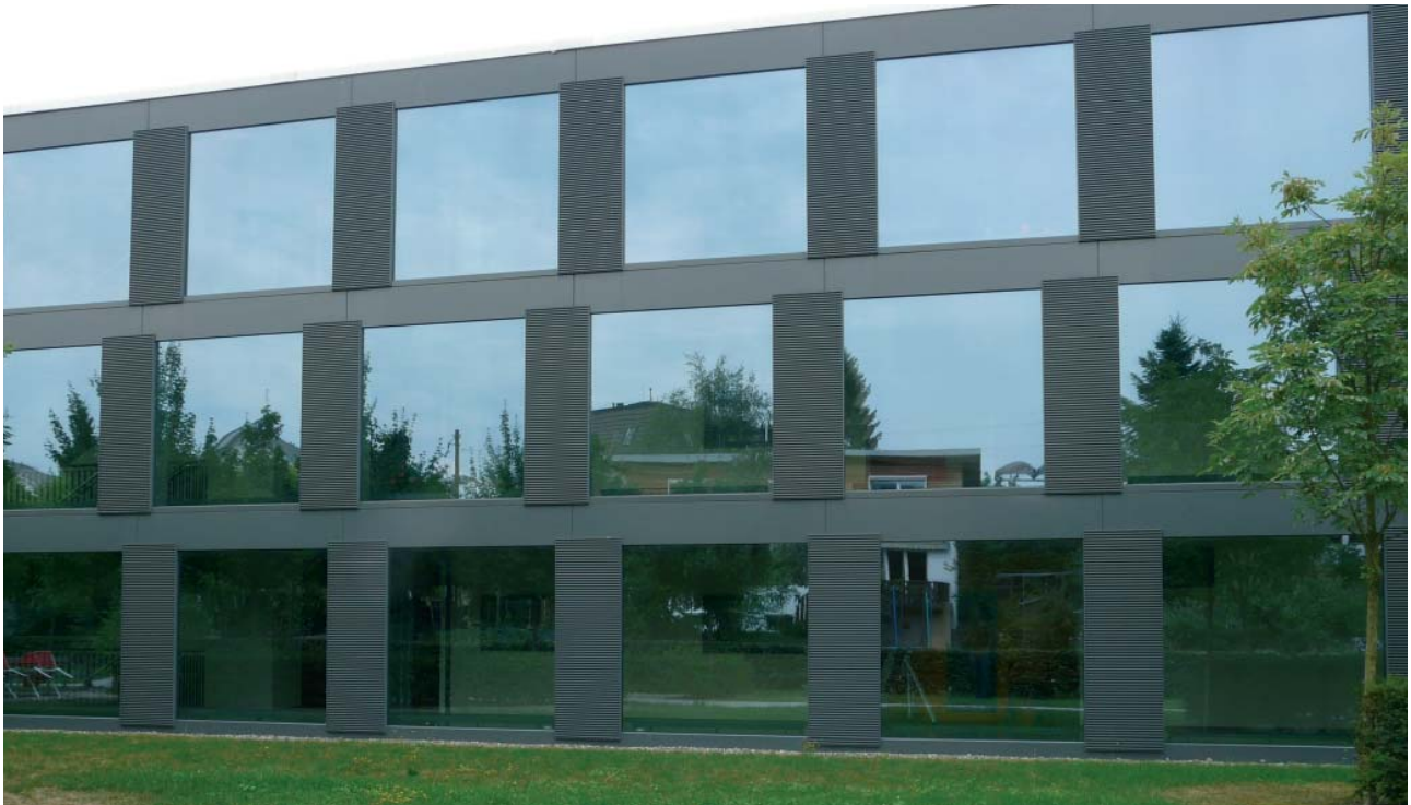
Les façanes grans, amb vidre fortament reflexiu, enmig d'un entorn enjardinat: un parany mortal, que només pel cost econòmic que tindria ja no es pot rectificar.
