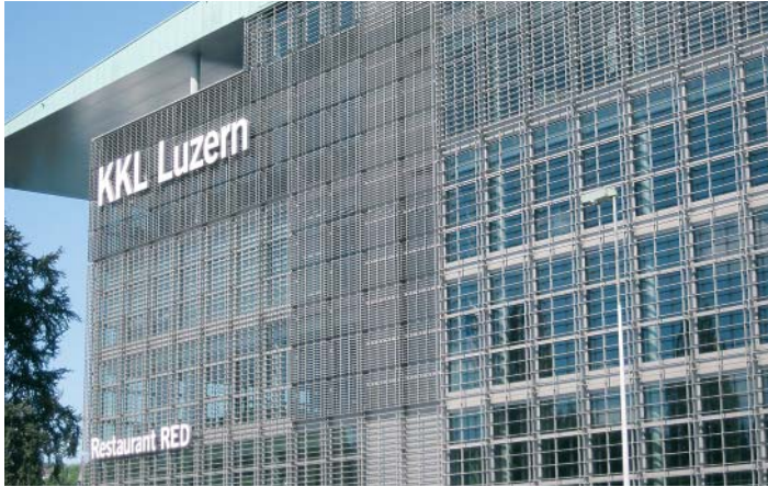
Façana de metall col·locada al davant de la façana de l'edifici.
