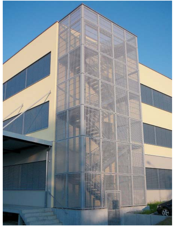
Malla de filferro: transmet la llum, és econòmica, i no és perillosa per als ocells.
