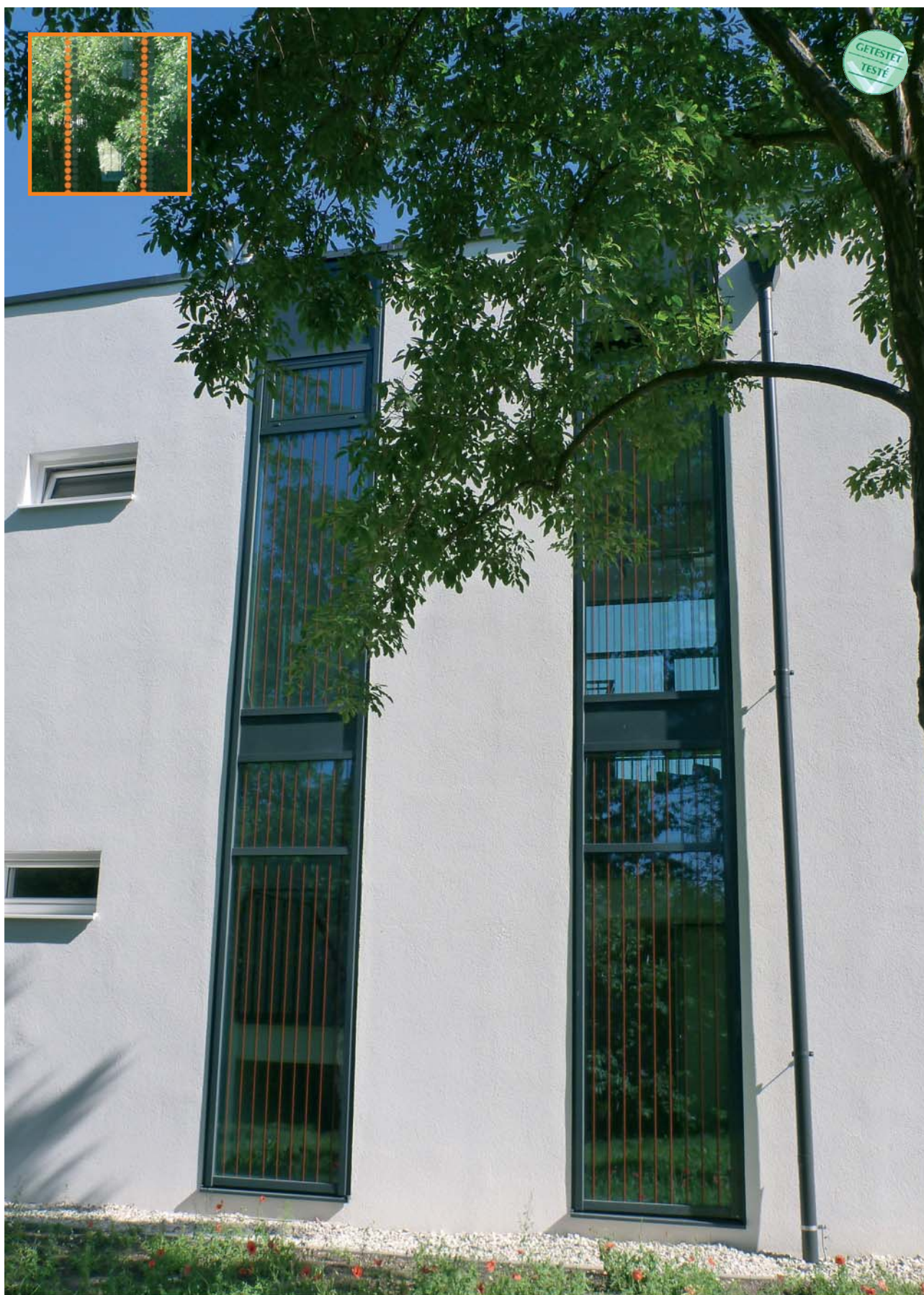
Un dels patrons que a la prova de túnel de vol va ser altament eficaç ja està disponible d'origen, de manera que no cal imprimir el patró després.
