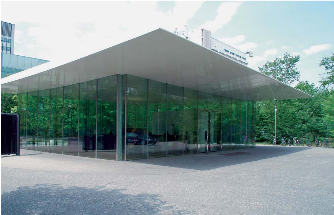
Edifici de recepció d'una gran empresa industrial. El conjunt òptic dels espais interiors i exteriors és molt perillós per als ocells. Els edificis vora l'aigua o en espais verds també són perillosos quan les façanes reflectants s'integren en l'entorn.
